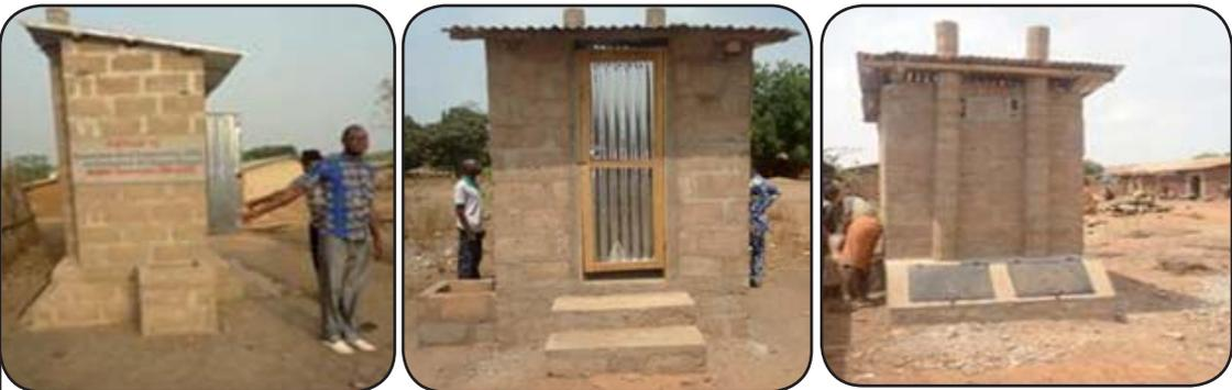
***Vue de côté, de face et de derrière des modules de latrines familiales ECOSAN entièrement réalisées par les artisans maçons locaux***
