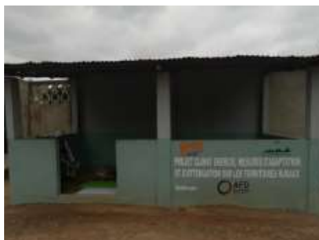
Figure 4 : Atelier de production du ferblantier après aménagement et travaux
